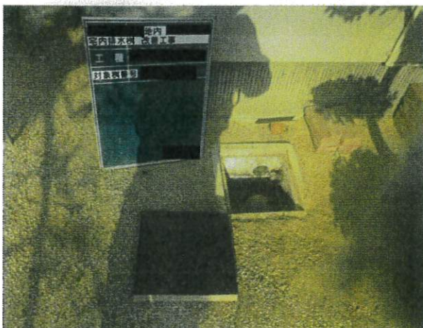
②樹 ゴムシート張り完了
